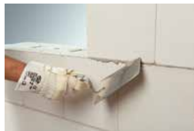
Odstránenie vytlačených zvyškov malty hranou lyžice po jej zavädnutí
