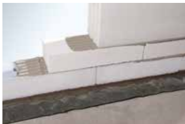
Založenie prvého radu pomocou tvárnic Ytong Start
